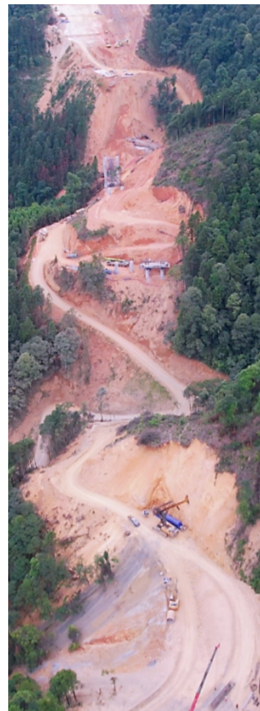
栗树湾施工便道
